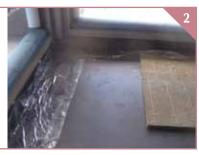
玻璃棉防震隔音墊 EP2 鋪設
