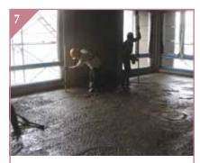
混凝土澆置、高程 控制隨打隨測
