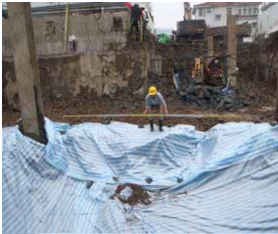
改善作為：設置沉沙池
