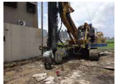
1-6. 鑽頭安裝 + 試鑽
