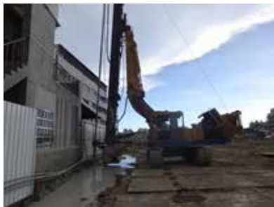
1-10. 拌漿 + 注漿 = 鑽機側
