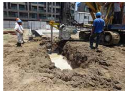
2-6. 掩埋廢棄物區域攪拌樁地改
