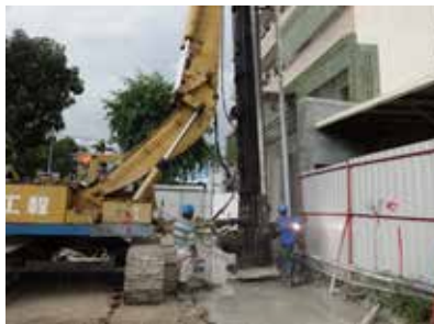
1-11. L=32m-#8(16m+16m) 鋼筋焊接 + 植入
