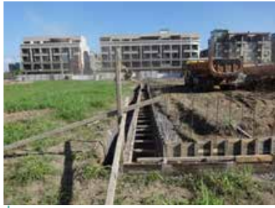
2-8. 第二階導溝施築
