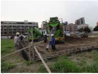
2-7. 第一階導溝施築
