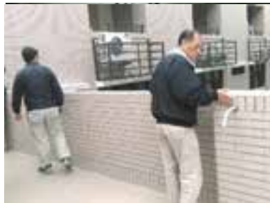
太子花漾 - 公設屋頂女兒牆無明顯裂縫
