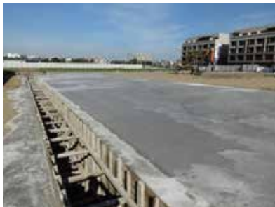
2-10. 第二階鋪面施築完成
