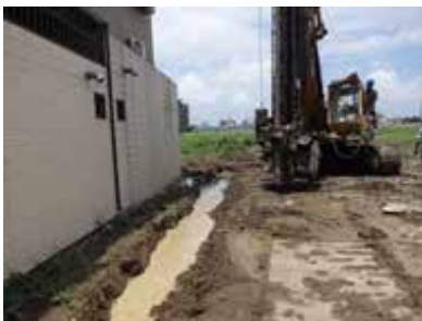
1-5. 樁位放樣 + 漿溝挖掘
