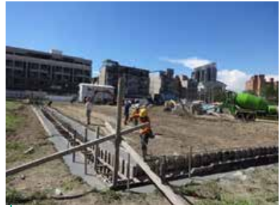
2-9. 第一階鋪面施築
