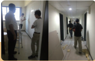
▲ 主管工程施工視察
