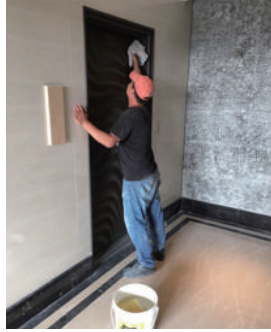
施工中-清除牆面粉塵
