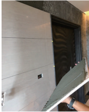
施工中-牆面、壁磚雙面背填黏著劑
