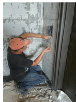
2 施工中-拆卸牆面器具及空心壁磚拆除
