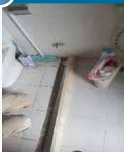
7 施工中 - 安裝人造石門檻
