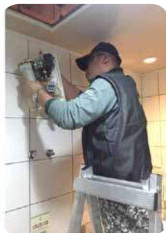
▲ 固定新電熱水器安裝
