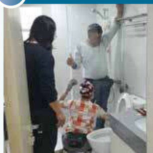
5 施工中 - 拆除淋浴拉門
