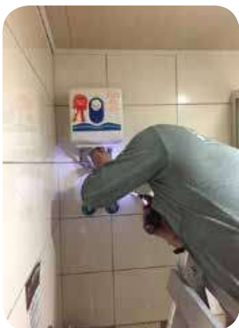
▲ 拆除舊電熱水器
