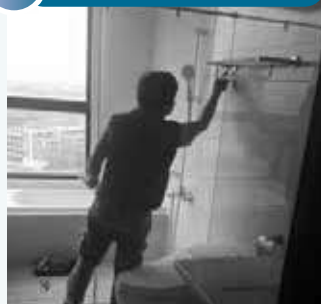
8 施工中 - 復原淋浴拉門
