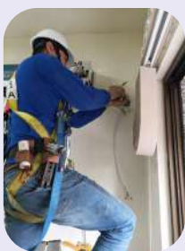
• 房內冷氣汰換工程
