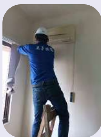
• 房內冷氣汰換工程
