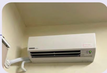
• 房內冷氣汰換工程
