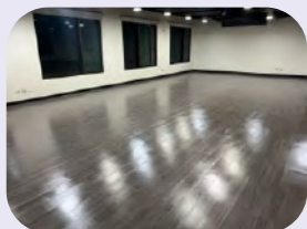
• 水源交誼廳地面整平更新工程 - 「踢腳板施工及清潔打蠟」
