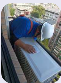
• 房內冷氣汰換工程
