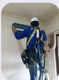
• 房內冷氣汰換工程
