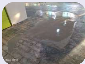
• 水源交誼廳地面整平更新工程 - 「自平泥工程」
