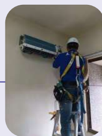
• 房內冷氣汰換工程
