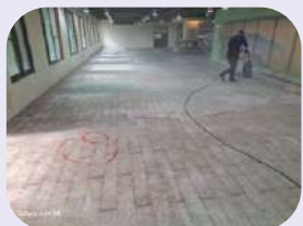
• 水源交誼廳地面整平更新工程 - 「磨平」
