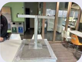
• 水源交誼廳桌面翻修工程
