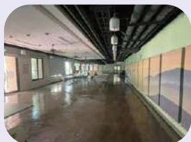
• 水源交誼廳地面整平更新工程 - 「施工前」
