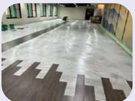
• 水源交誼廳地面整平更新工程 - 「地磚施作照」
