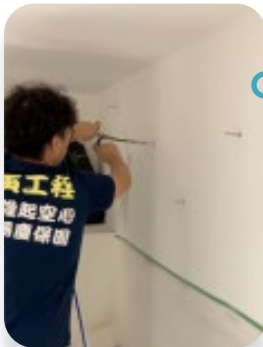
高壓注入環氧樹脂，以進行填補空隙
