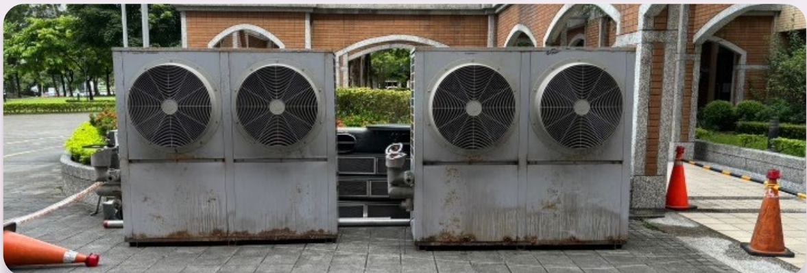
長興、水源交誼廳冰水主機及送風機汰換
